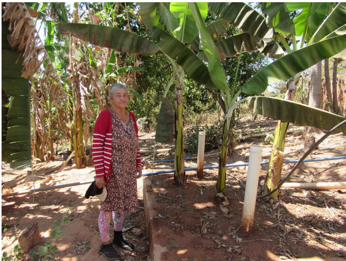
Dona Adair Gonçalves, beneficiária da comunidade de José Silva, recebeu em sua propriedade 01 fossa séptica TEVAP e 01 sistema de reuso da água.
