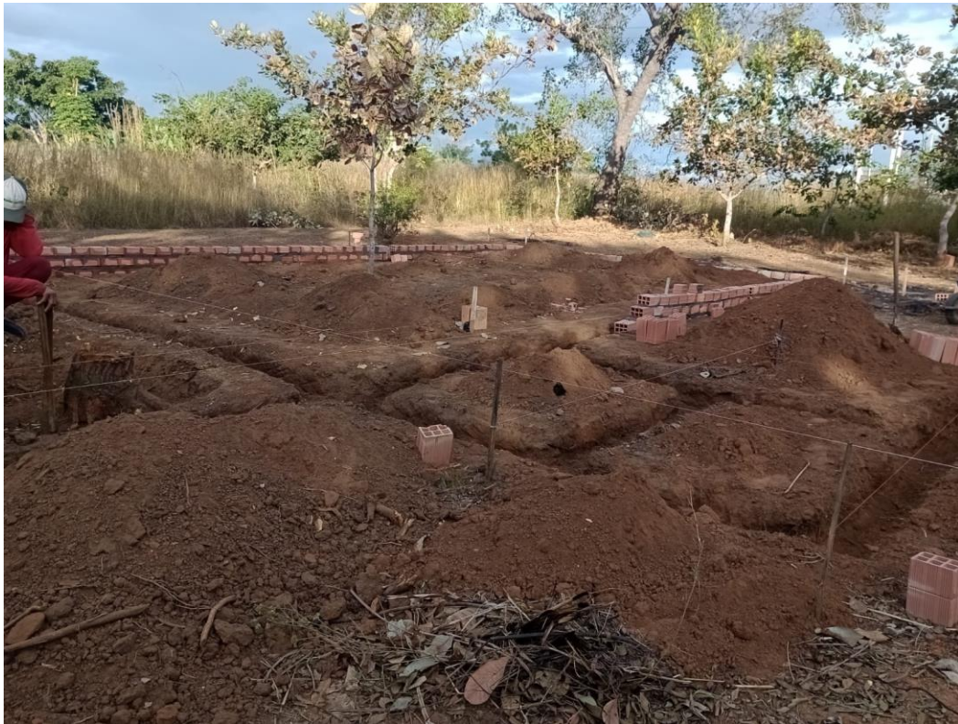
Foto – Locação da obra
