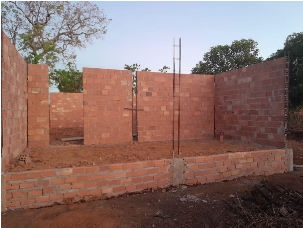
Foto 3 – levantamento das paredes
