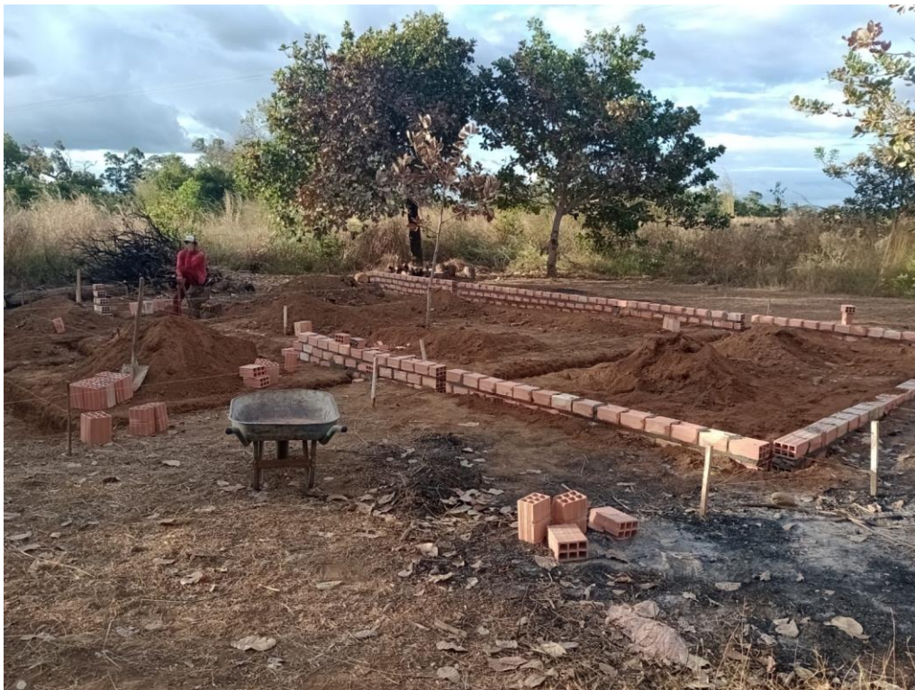
Foto 2 - Início da obra
