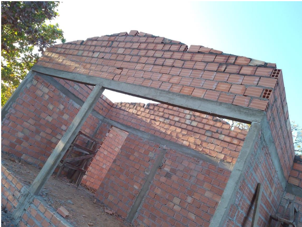
Foto 4 – levantamento das paredes
