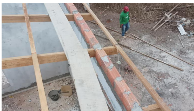
Figura 2 ALVENARIA DE VEDAÇÃO DE BLOCOS CERÂMICOS FURADOS NA HORIZONTAL DE 9X19X19 CM (ESPESSURA 9 CM)
