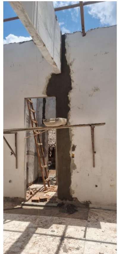
Figura 28 MASSA ÚNICA, PARA RECEBIMENTO DE PINTURA, EM ARGAMASSA
