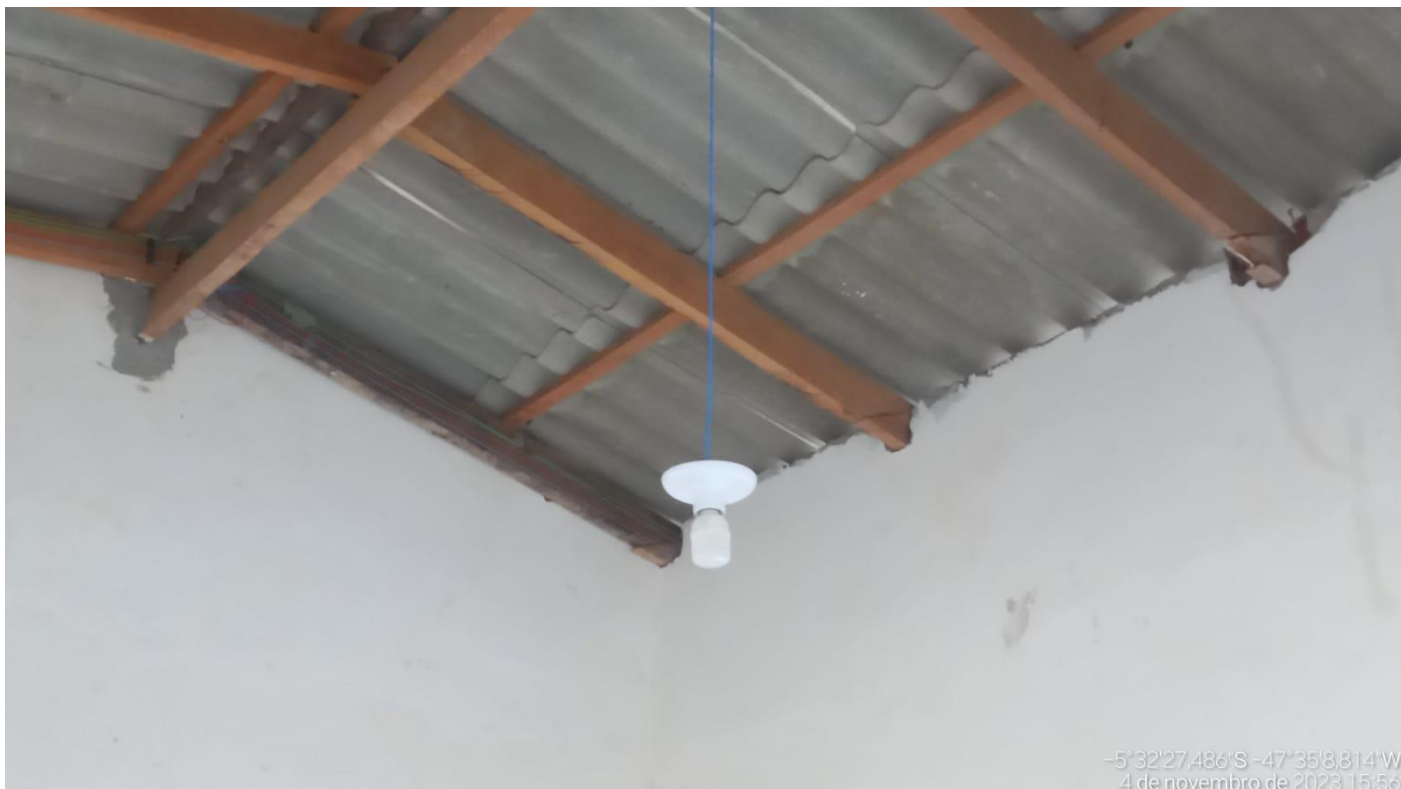
Figura 7 - LAMPADA DE LED 20 W 6500 K COM PLAFON PLASTICO. FORNECIMENTO E INSTALAÇÃO
