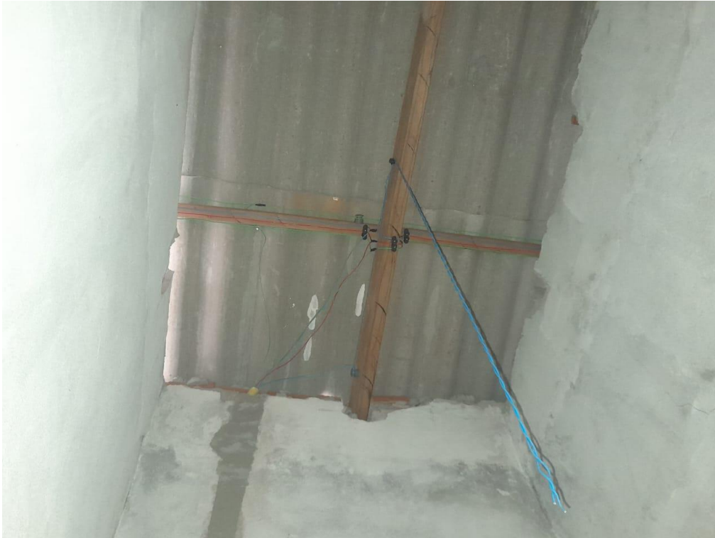
Figura 12 - INSTALAÇÕES ELÉTRICAS DIVIDIDA EM CIRCUITIO DE ILUMINAÇÃO E TOMADAS DE USO GERAL.
