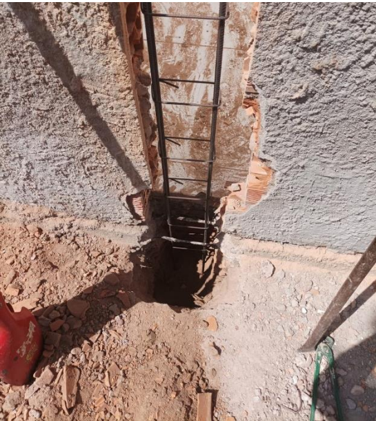
Figura 18 – estaca broca de concreto
