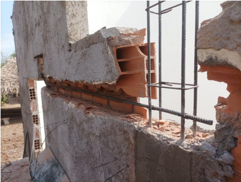
Figura 12 - armação de pilar de concreto armado utilizando aço ca-50 de 10,0 mm
