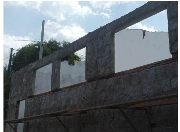
Figura 17 - demolição de alvenaria de bloco furado para execução contraverga
