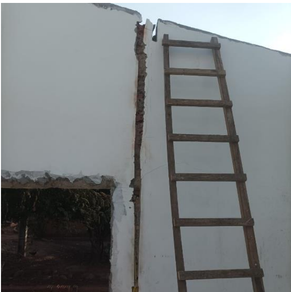
Figura 9 - rasgo em alvenaria para eletrodutos
