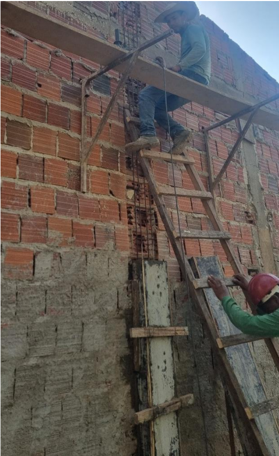
Figura 15 - fôrma de pilares retangulares
