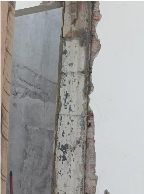
Figura 14 - PILAR DE CONCRETO FCK = 25MPA (
