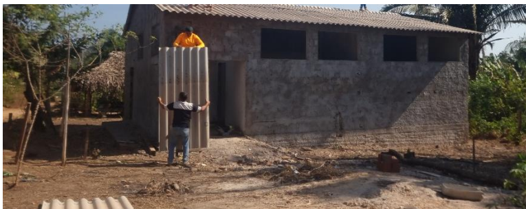
Figura 1 - Limpeza do do terreno
