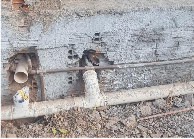
Figura 7 - instalação de tubos de pvc, soldável, água fria, dn 25 mm
