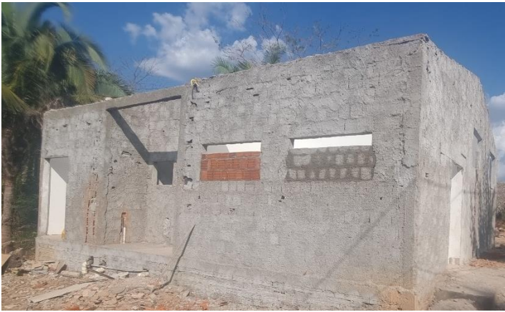
Figura 4 - alvenaria de vedação de blocos cerâmicos furados na horizontal de 9x19x19 cm utilizado para padronizar a altura das janelas
