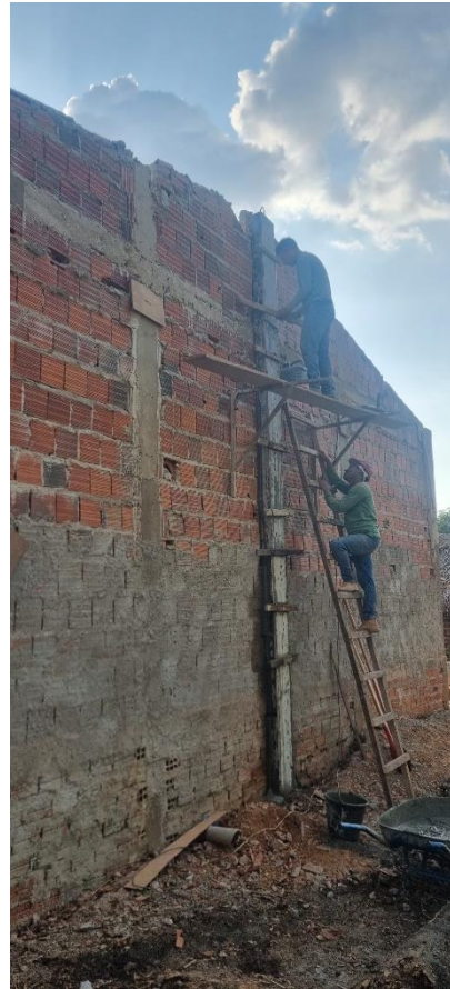
Figura 16 - . concretagem dos pilares com lançamento manual.
