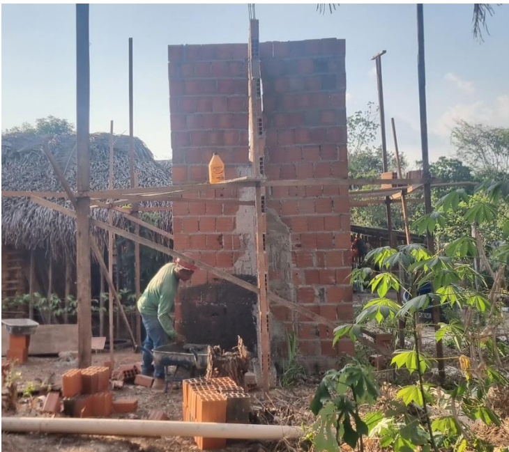
Figura 5 - alvenaria de vedação de blocos cerâmicos furados na horizontal de 9x19x19 cm utilizado para subir o nível do reservatório de água fria.
