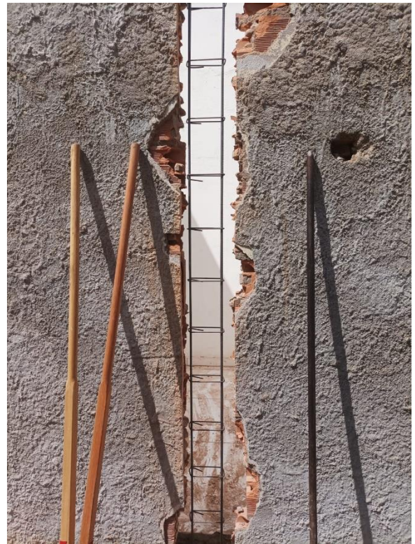
Figura 13 - Armação de pilar com ferro 10mm e estribos 5mm
