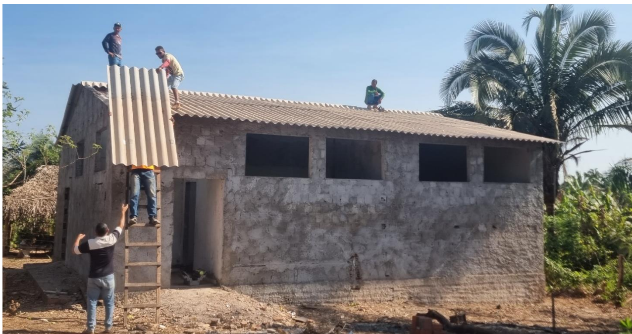
Figura 10 - retirada da telha fibrocimento.
