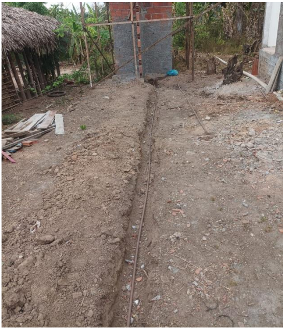
Figura 8 - escavação manual de vala com profundidade menor ou igual a 1,30 m.
