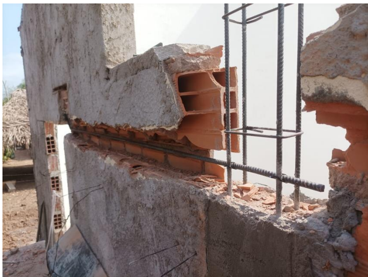
Figura 3 Demolição de argamassas e alvenaria
