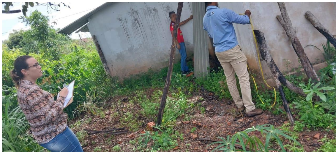
Figura 8 Medição da área de construção da agroindústria
