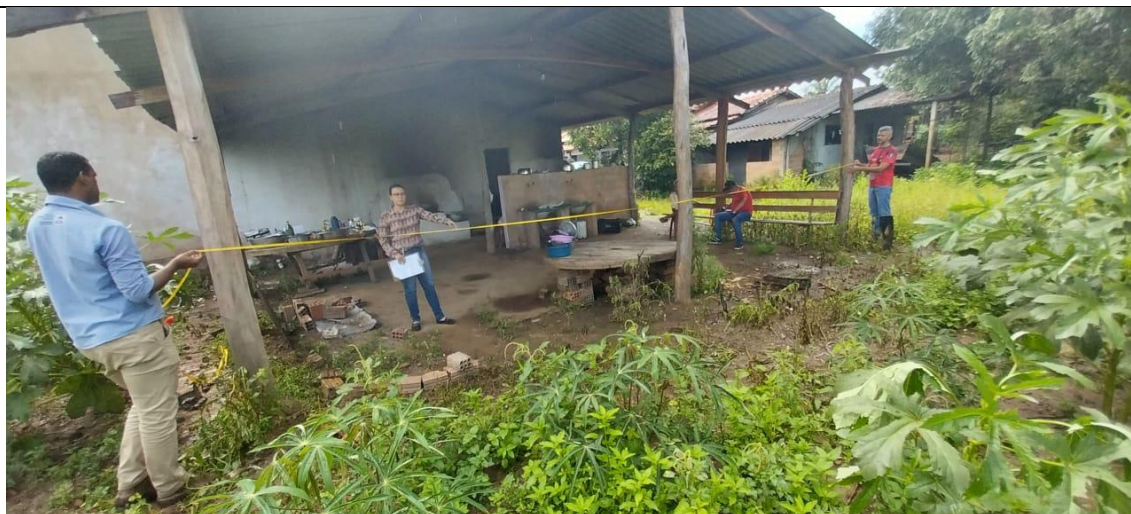
Figura 10 Medição da área de construção da agroindústria
