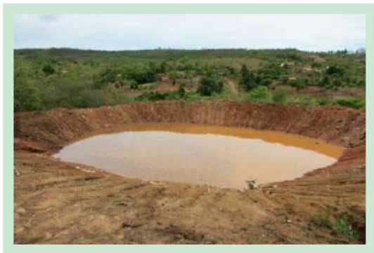
Bacia de contenção na comunidade de Pontezinha em Veredinha (MG)
