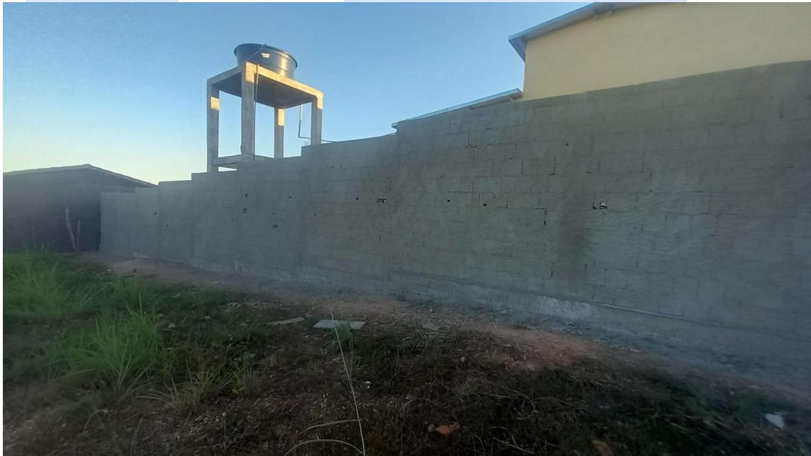
Figura 3 – Chapisco traço 1:3 aplicado com colher de pedreiro em muro de divisa, pano de parede extena.
