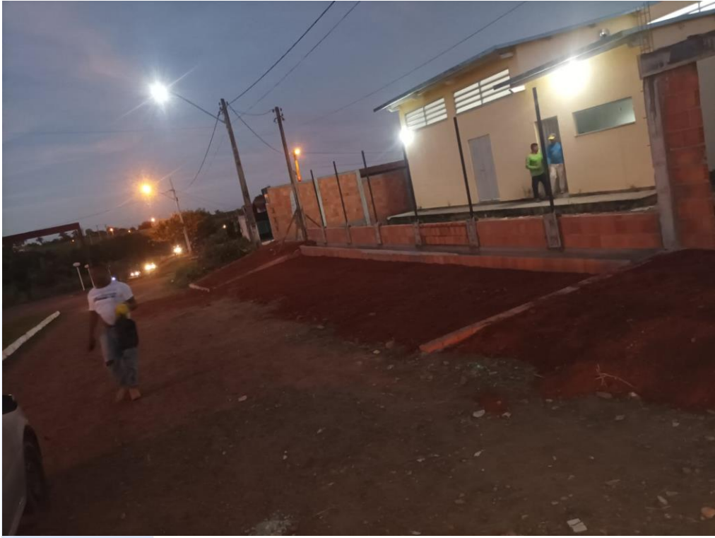
Figura 2 - Preparo de terreno, com enchimento de material utilizando caminhão basculante, espalhamento manual e compactação com compactador a percussão.
