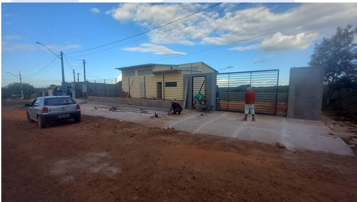
Figura 11 - Pátio de concreto executado na frente da edificação e portões metálicos montados com metalons quadrado 25x25mm.
