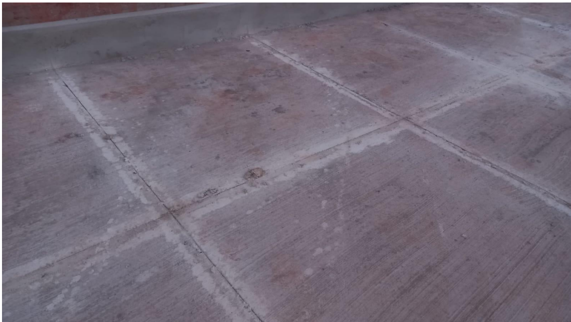
Figura 10 - Juntas de dilatação secas executadas com cortadoura de piso, pátio de concreto.
