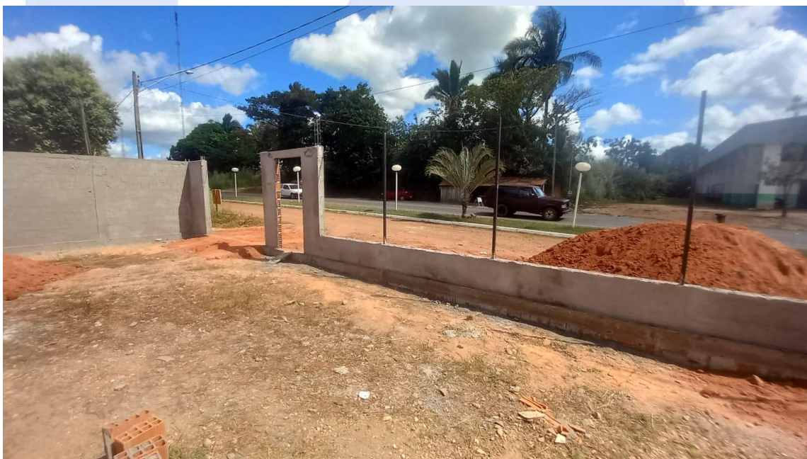
Figura 5. Execução de massa única (reboco) em paredes e muretas da fachada, instalação de postes metálicos para recebimento de gradil.
