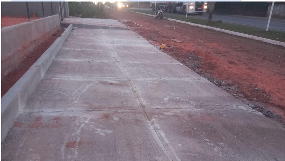
Figura 9 - Pátio de concreto para estacionamento de veículos, fachada frontal.
