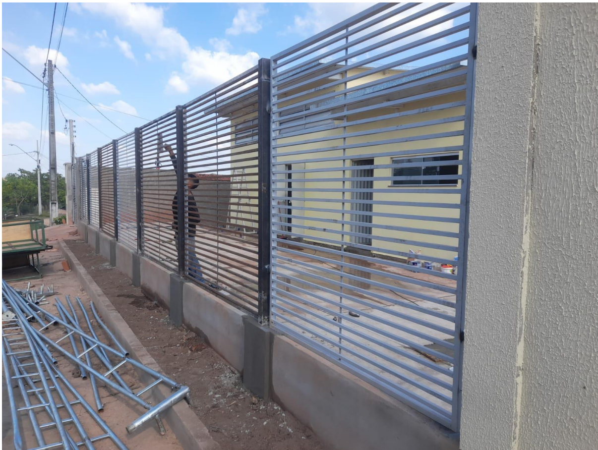
Figura 5 - Adequação de gradil frontal e pintura com tinta esmalte sintético.
