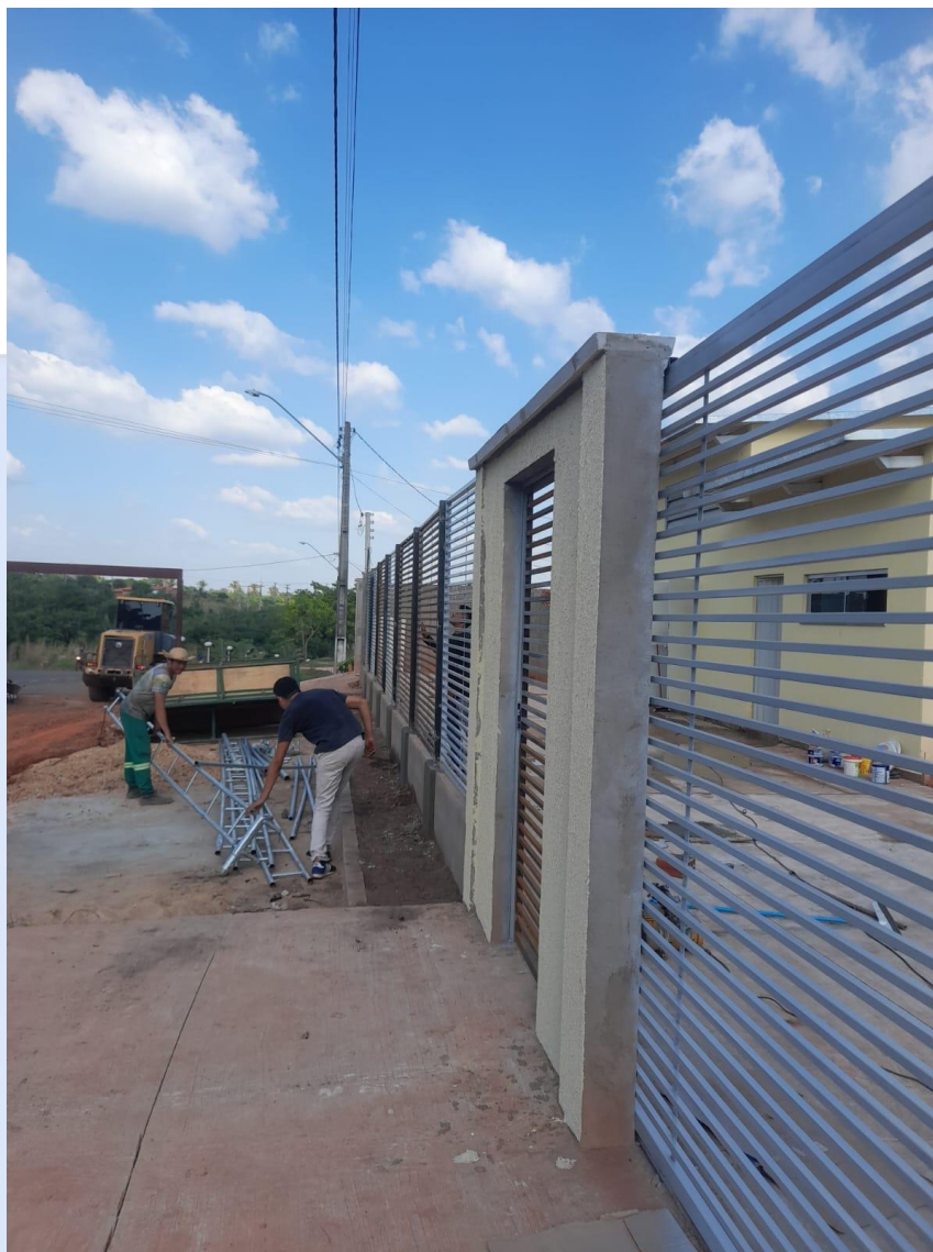
Figura 4 - Fachada da edificação com grade montada, portões instalados.
