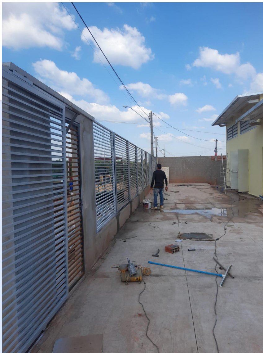
Figura 3 - Portão social e grade fontral executados em metalons 25x25 mm, e poste com perfil quadrado 90x90 mm, chapa 14.
