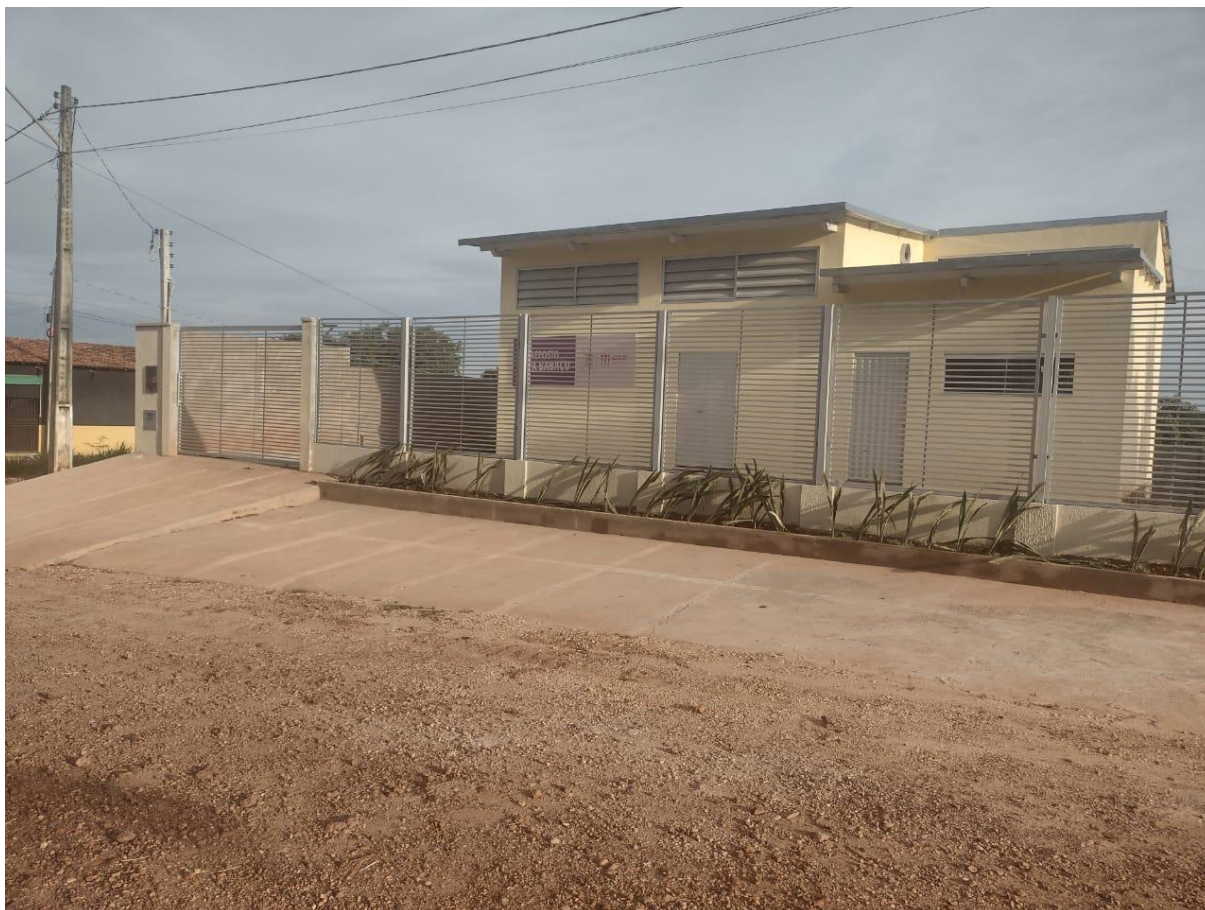
Figura 7 - Fachada da edificação com grades e portões pintadas com tinta esmalte sintético, mureta e parede com textura acrílica.
