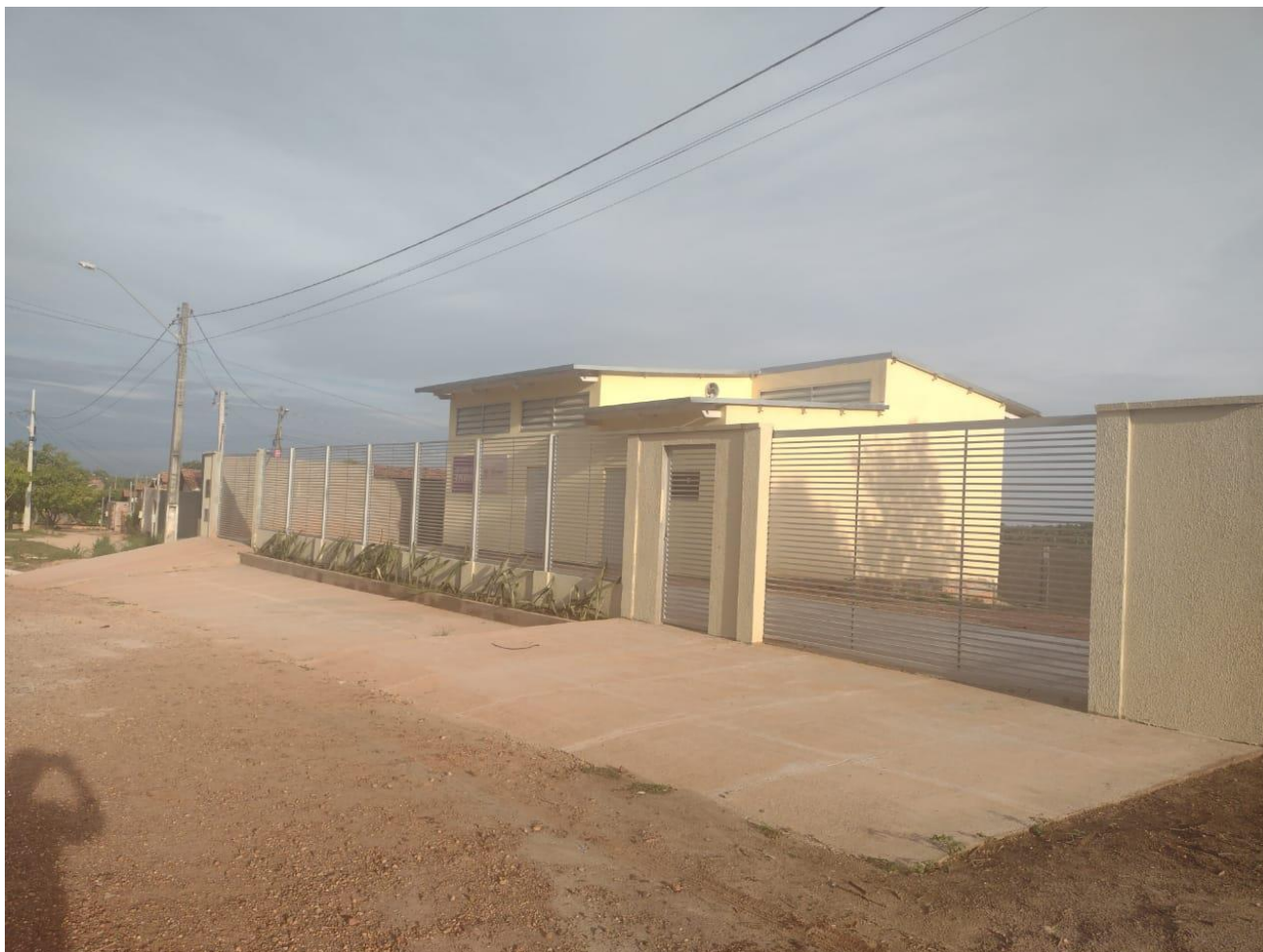
Figura 6 - Fachada da edificação com grades e portões pintadas com tinta esmalte sintético, mureta e parede com textura acrílica.
