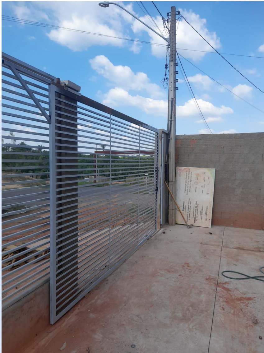
Figura 2 - Portão para veículos lado esquerdo da edificação montado com metalons 25x25mm.
