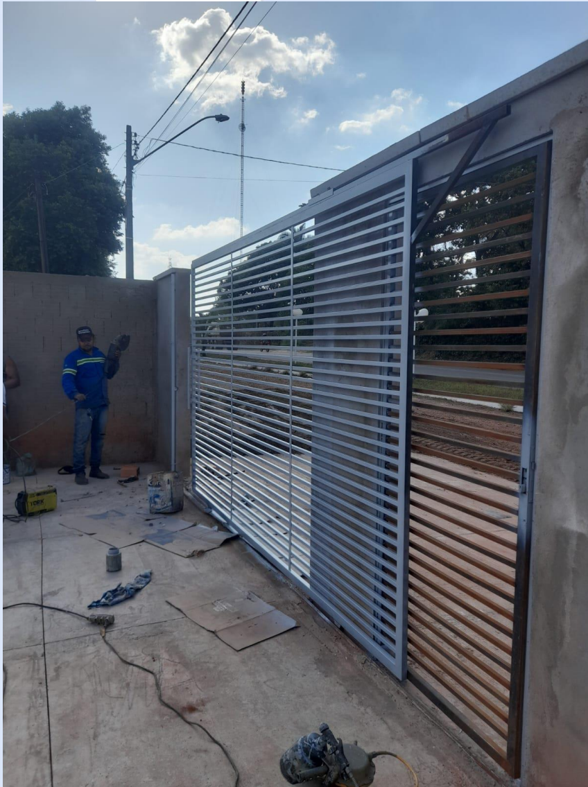
Figura 1 - Portão para veículos lado direito da edificação montado com metalons 25x25mm.
