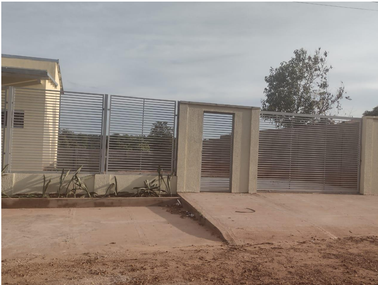
Figura 8 - Fachada da edificação com grades e portões pintadas com tinta esmalte sintético, mureta e parede com textura acrílica.
