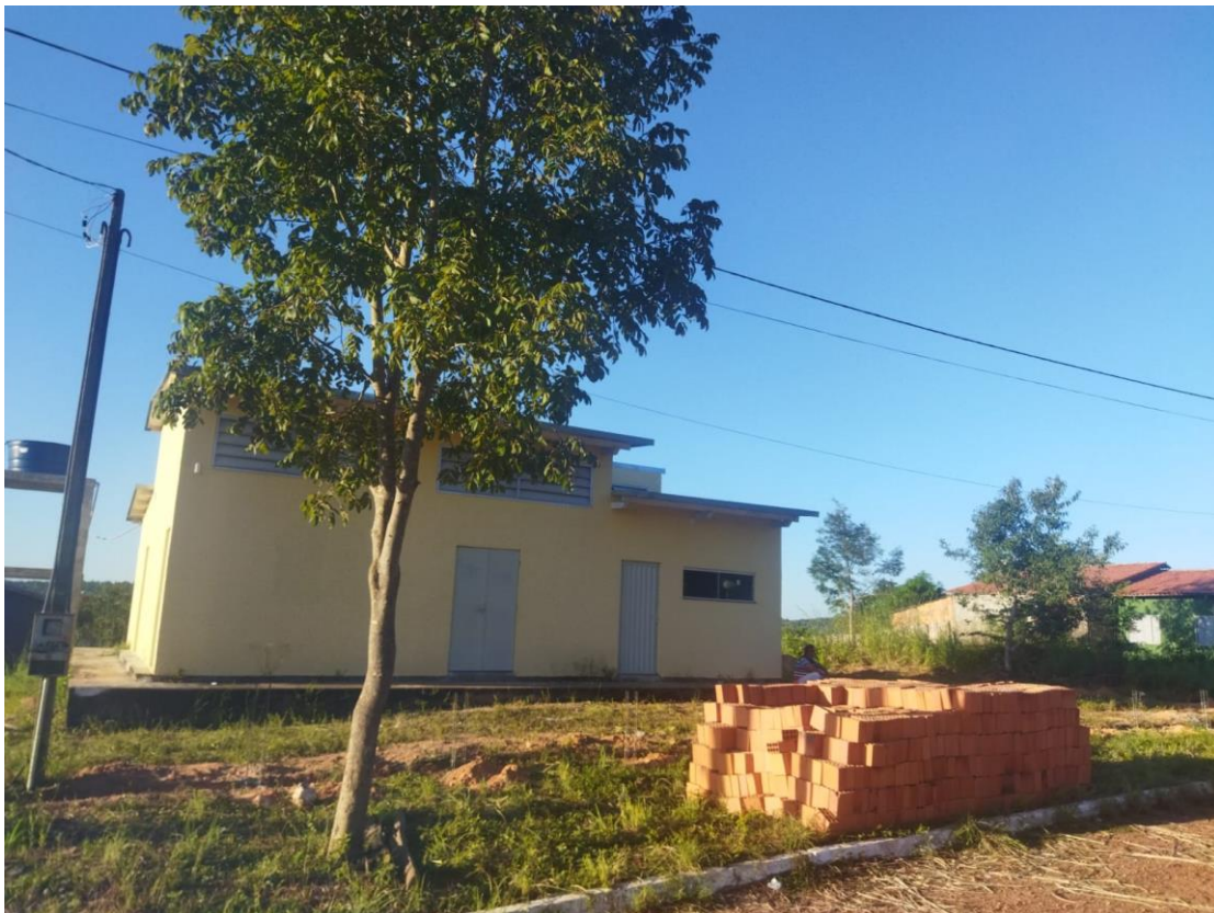
Figura 5. alvenaria ceramica para execuão do embasamento do muro de divisa baldrame.
