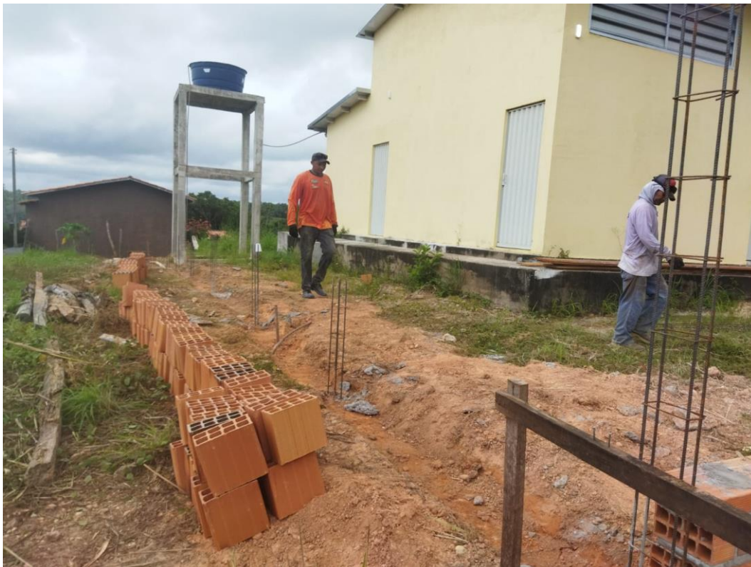
Figura 6. vala para embasamento e viga baldrame escavada e limpa.
