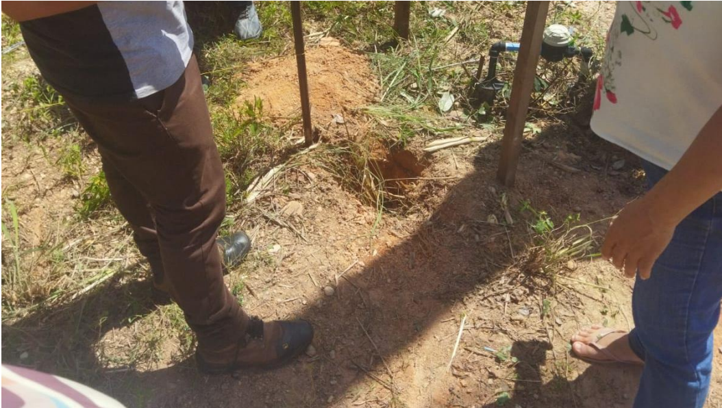
FIGURA 2. Escavação das estacas de fundação do muro de divisa.
