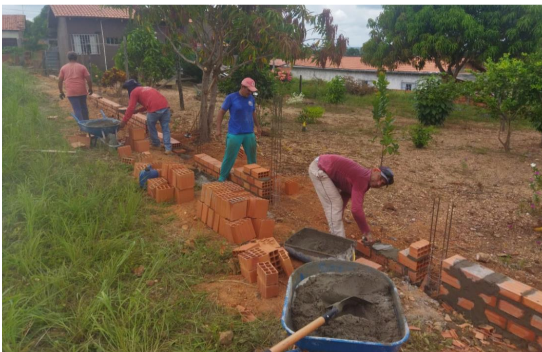
Figura 9. execução de embasamento no limite dos fundos do terreno.
