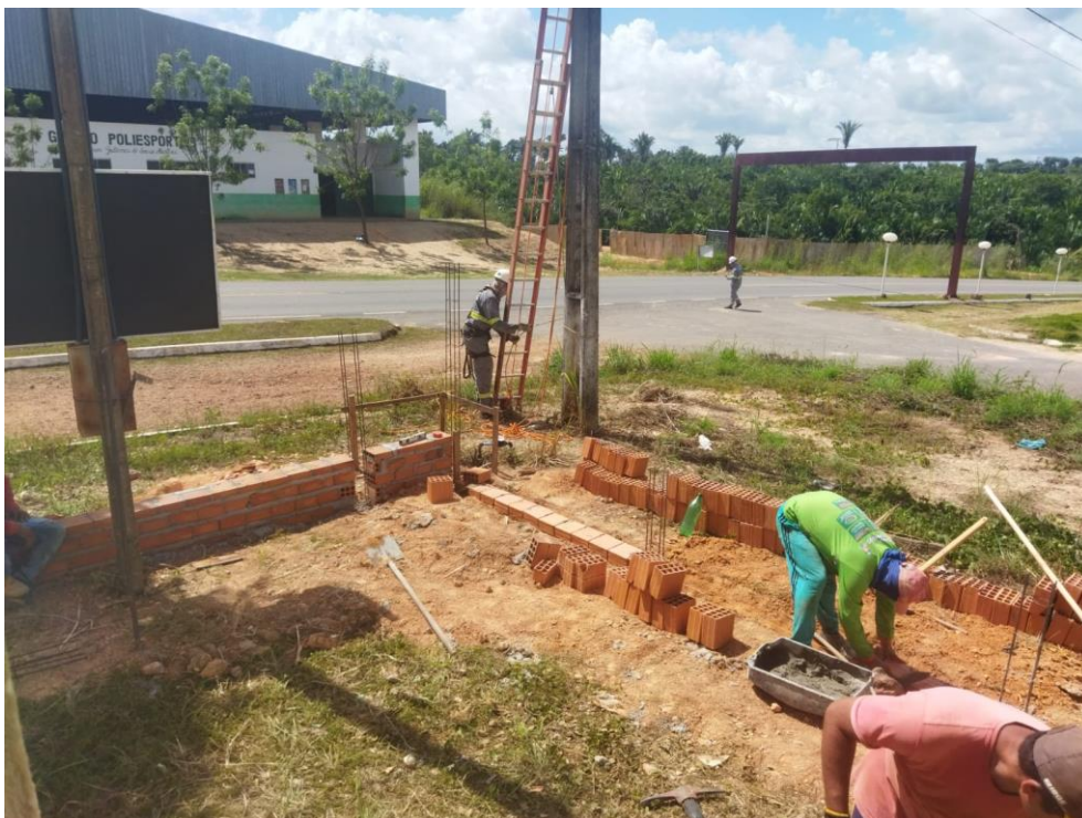
Figura 7. execução do embasamento para receber a viga baldrame em concreto armado.
