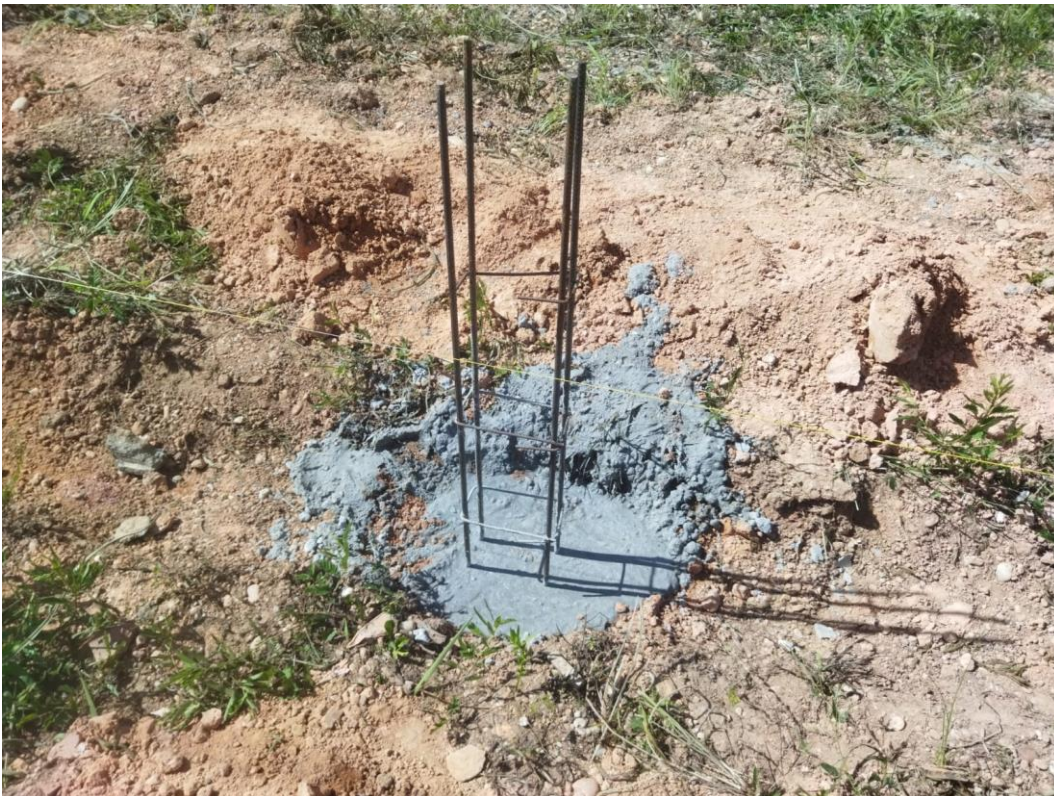
Figura 3. Estaca de concreto com diâmetro de 20 cm profundidade de 80 cm com arranque para pilar.
