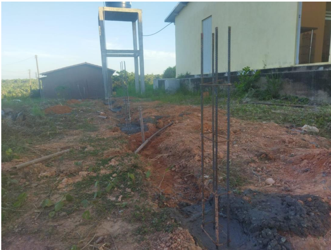
Figura 4. alinhamento de estacas da lateral esquerda do muro de divisa.
