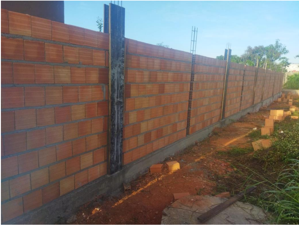
Figura 12. concretagem de pilares no alinhamento dos fundos.
