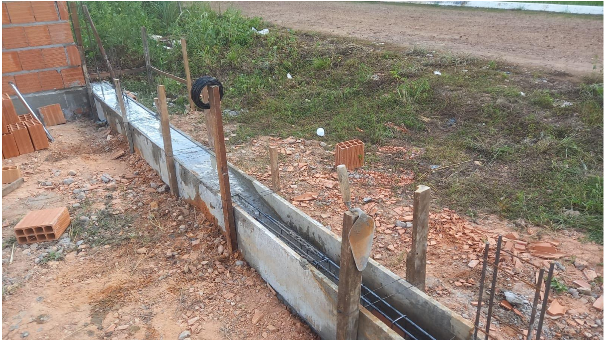
Figura 4. Processo de concretagem da viga baldrame da fachada.
