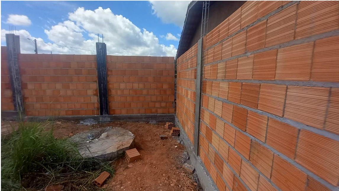
Figura 14. Pilares concretados no muro dos fundos.
