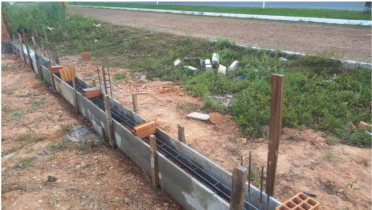
Figura 5. armação em colunas pop, formas em tabuas e concretagem de viga frontal da edificação.
