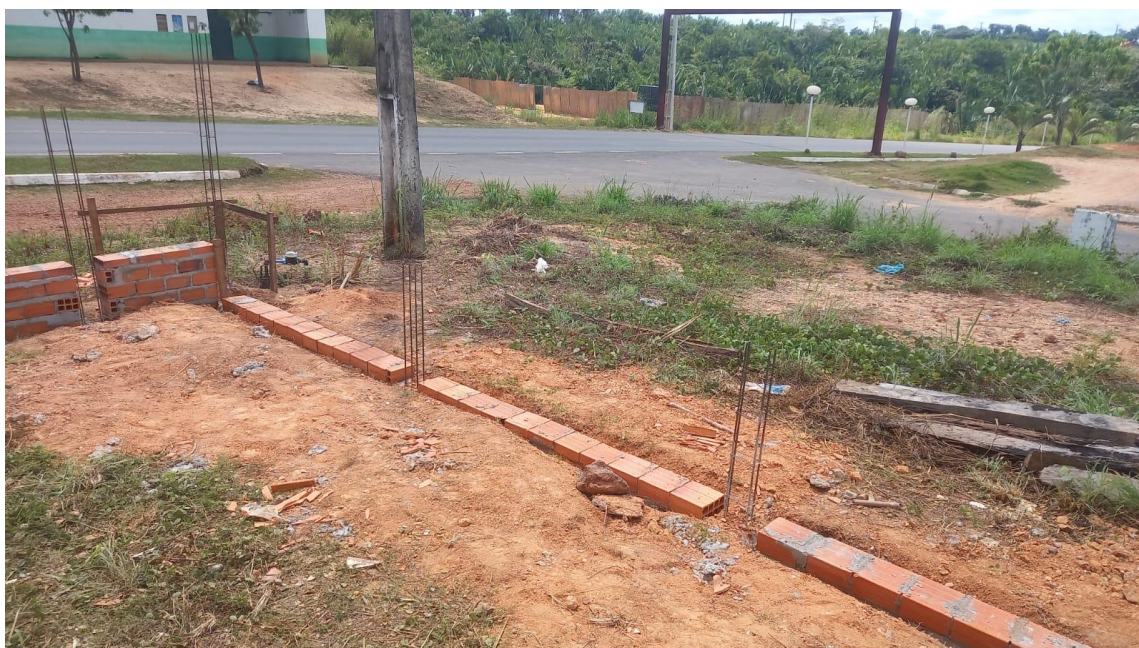
Figura 1. Embasamento para viga baldrame na lateral esquerda da edificação.
