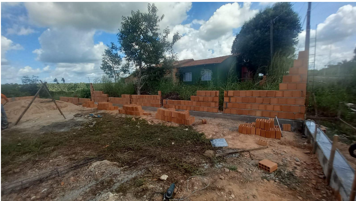
Figura 9. execução da alvenaria de vedação do muro na lateral direita.
