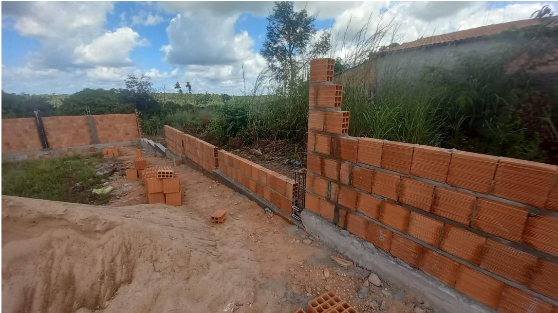
Figura 10. Execução de alvenaria de vedação na lateral direita.
