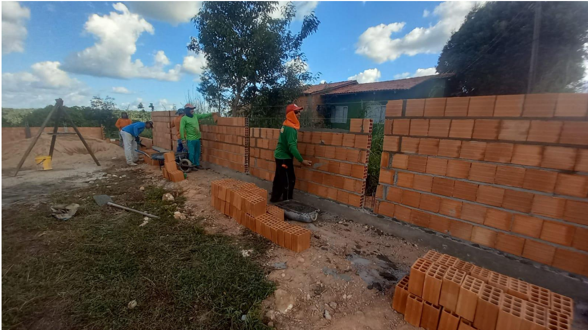
Figura 16. Alvenaria de vedação em execução, lateral direita.
