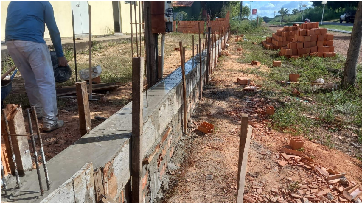
Figura 6. Viga baldrame frontal concretada.
