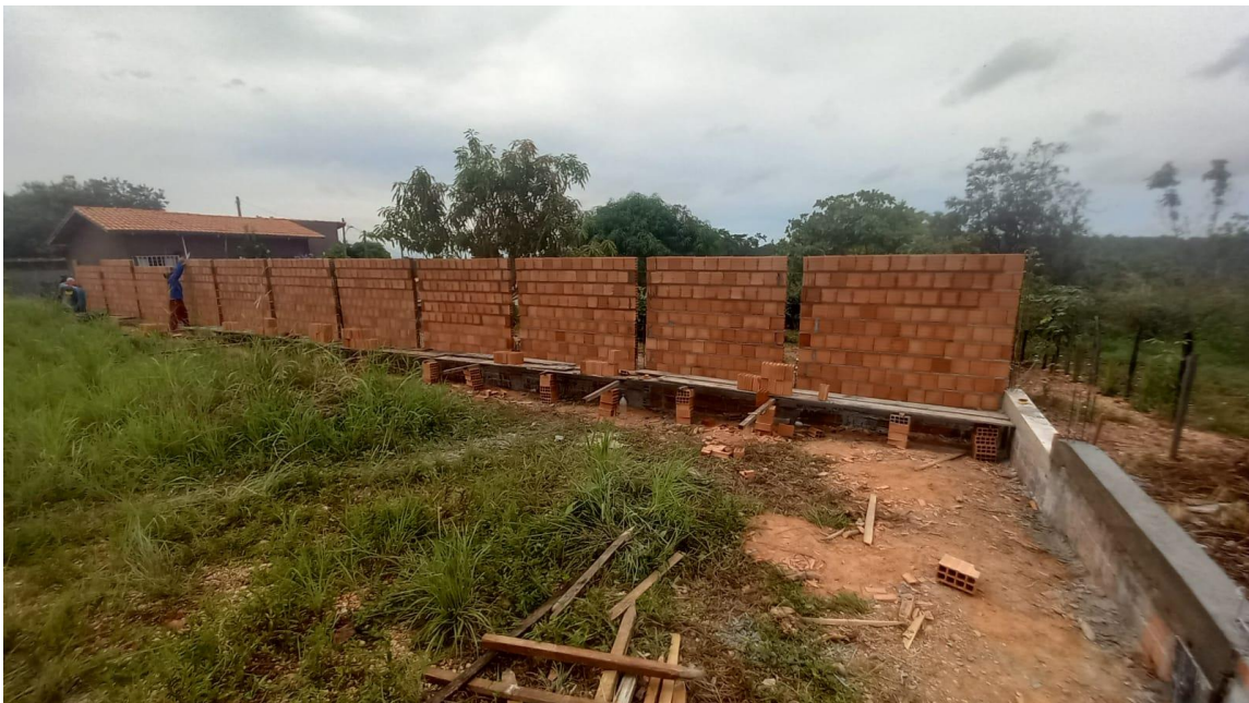
Figura 7. Alvenaria de vedação em execução no alinhamento do fundo.
