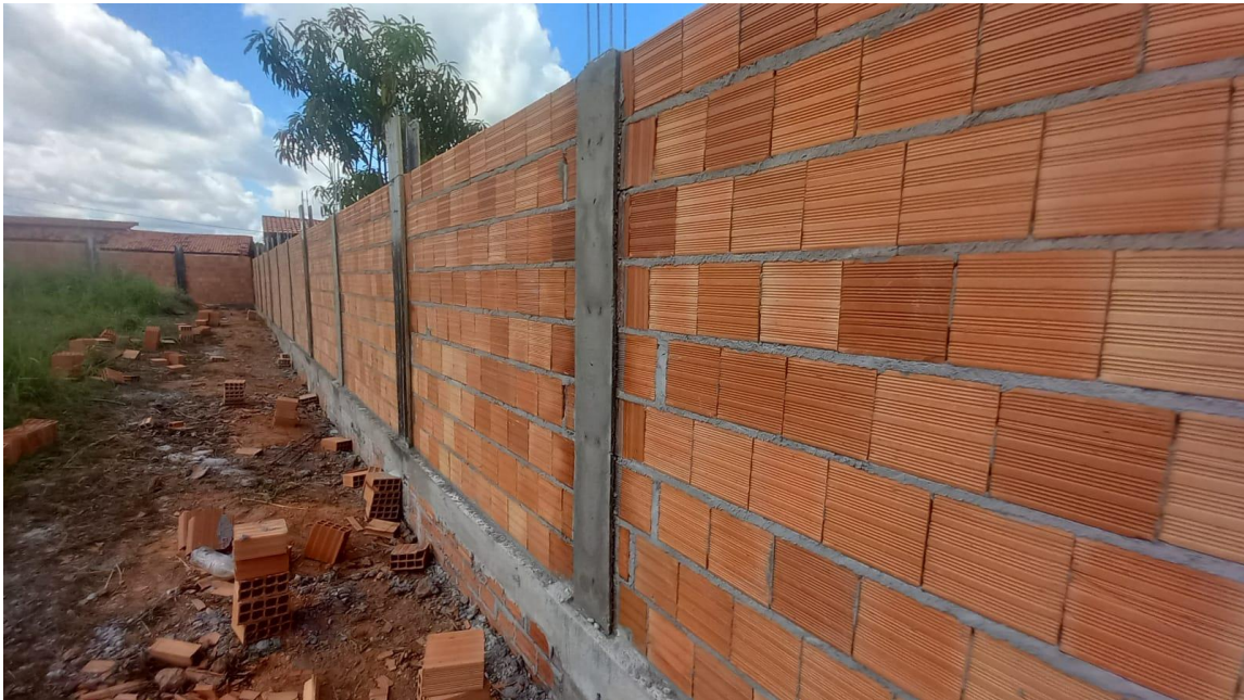
Figura 15. Pilares concretados no muro dos fundos.
