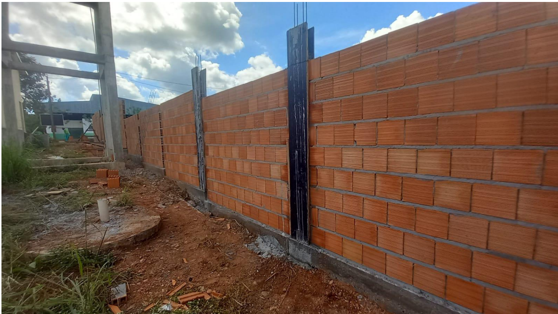
Figura 13. Concretagem de pilares no muro, alinhamento esquerdo.
