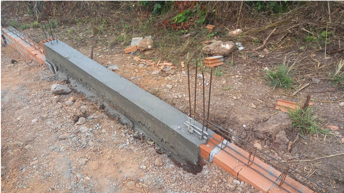
Figura 2. Viga baldrame concretada em degraus na lateral direita do terreno.
