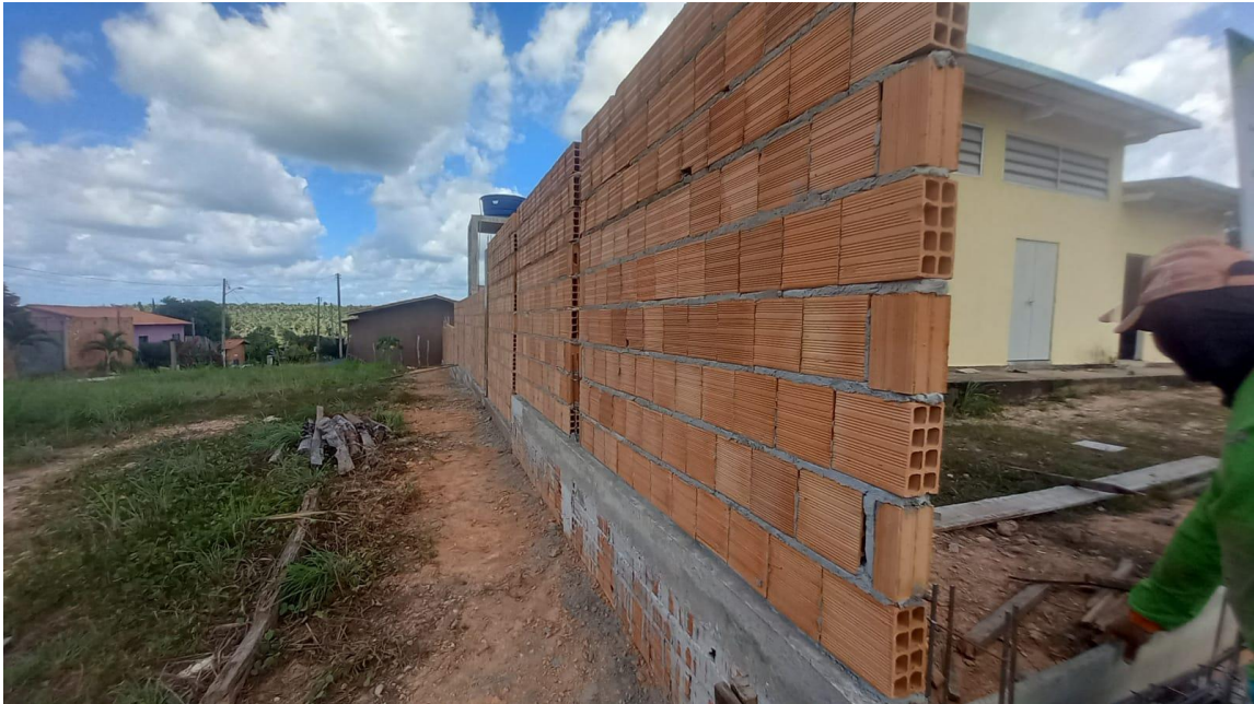
Figura 8. alvenaria de vedação da lateral esquerda do muro.
