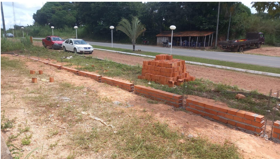
Figura 3. Alvenaria de embasamento executada em um único nível na fachada.
