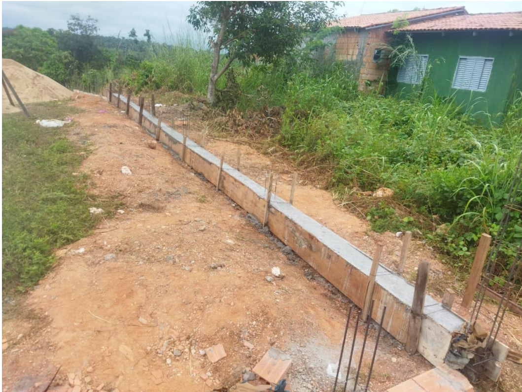
Figura 6. Viga da lateral direita concretada.
