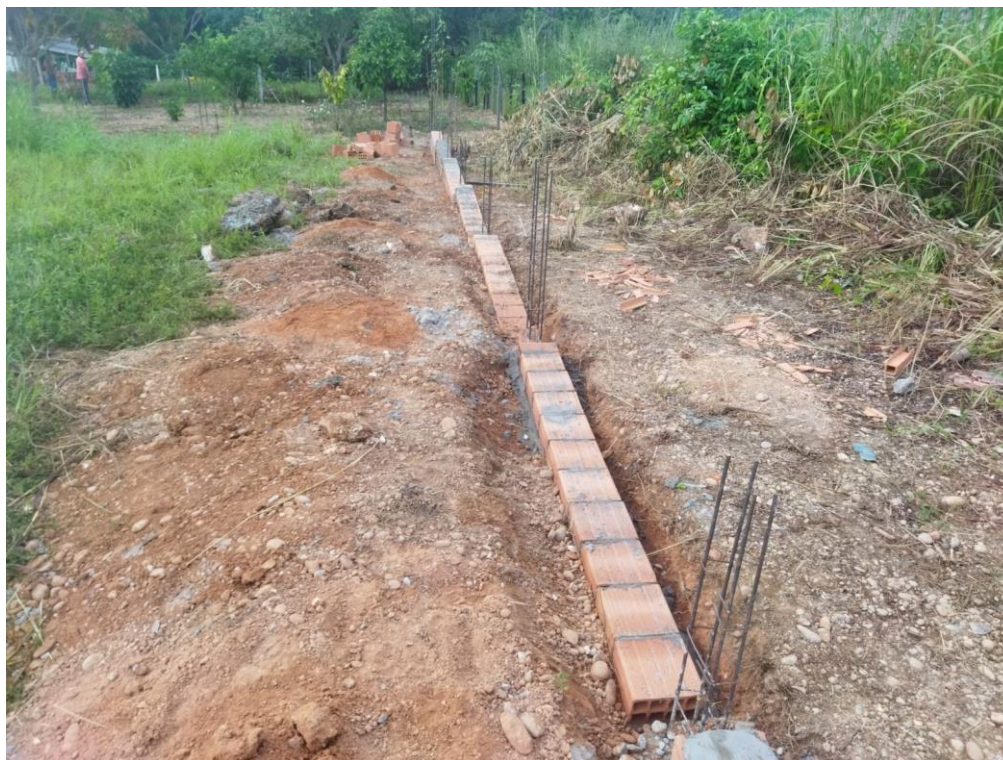
Figura 1. Embasamento do muro executado em degraus.
