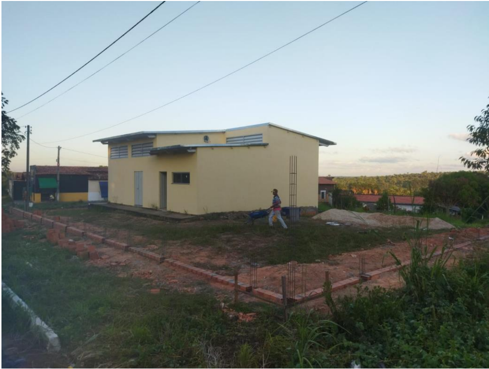
Figura 4. Vista lateral do muro após a conclusão da etapa de embasamento.
