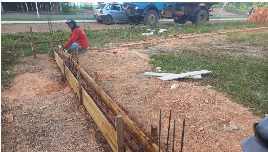
Figura 5. Montagem de formas para viga baldrame e colocação de armação de aço.
