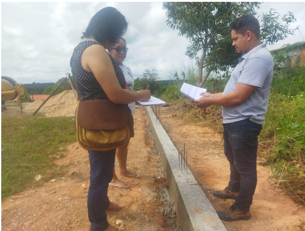
Figura 7. Viga baldrame após desmontagem da forma.
