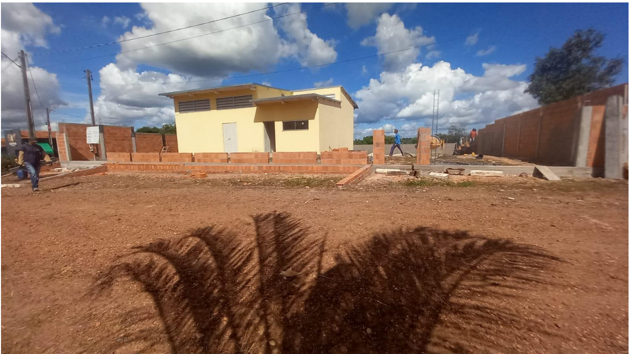
Figura 5. Vista frontal da edificação em processo de finalização da alvenaria.
