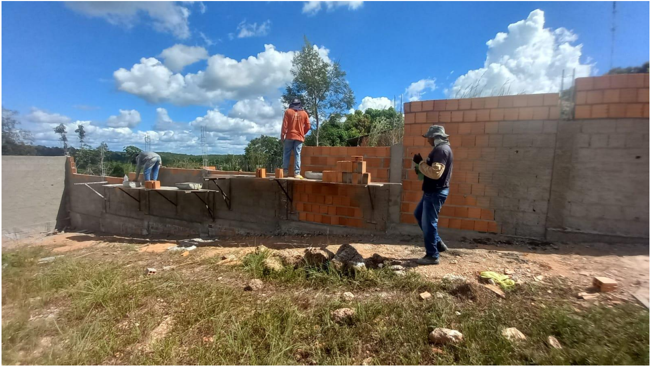
Figura 2. Finalização da alvenaria e concretagem dos pilares.
