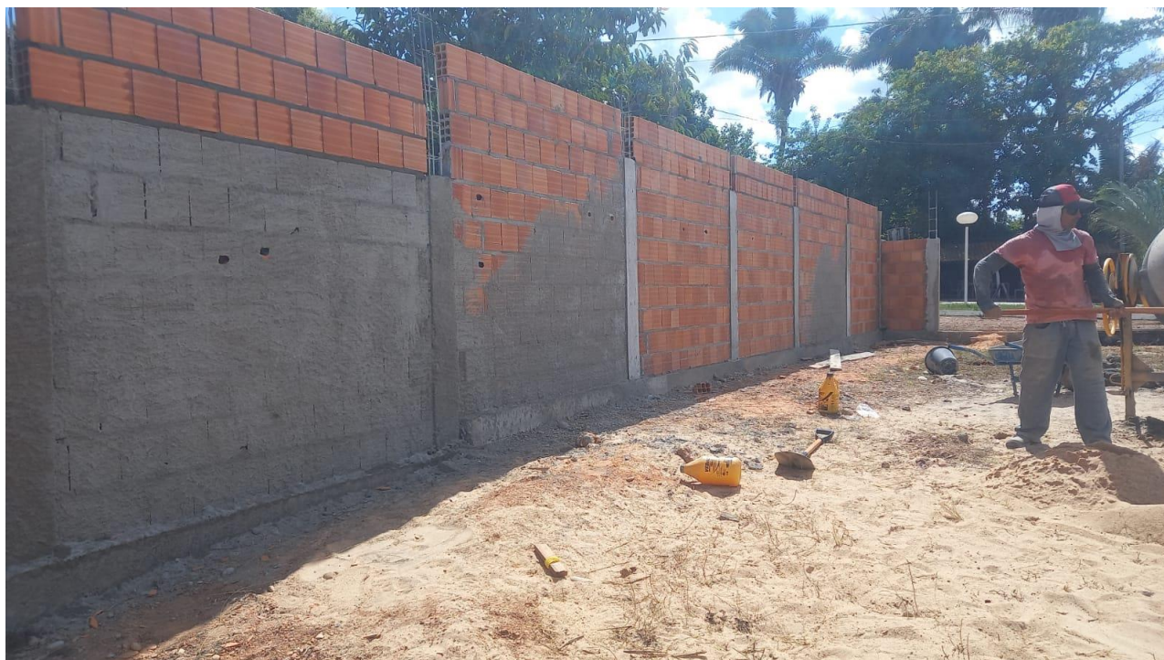
Figura 1. concretagem dos pilares do muro de divisa.
