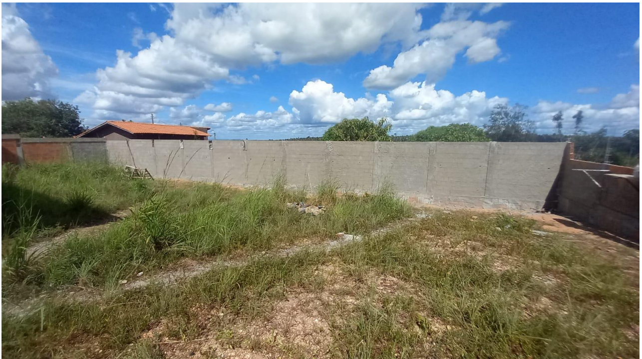
Figura 3. muro dos fundos em processo de concretagem das pontas dos pilares.
