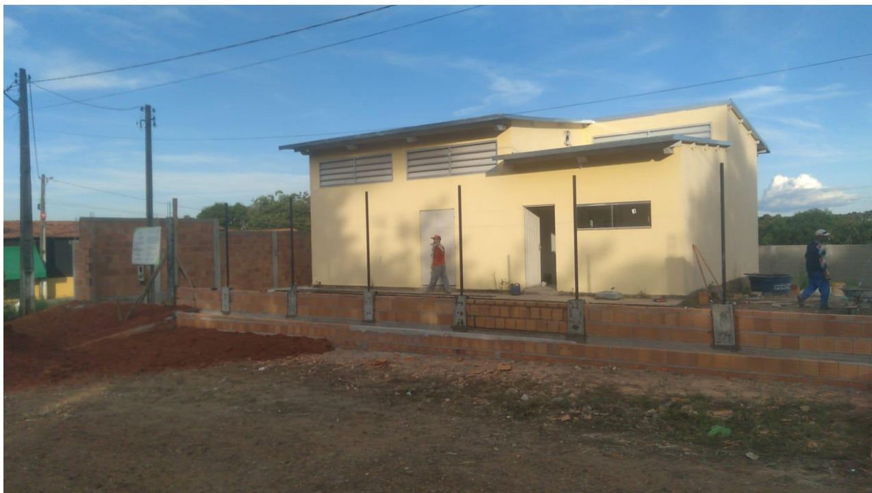
Figura 6. Concretagem dos pilaretes da fachada e chumbamento dos postes para alambrado.
