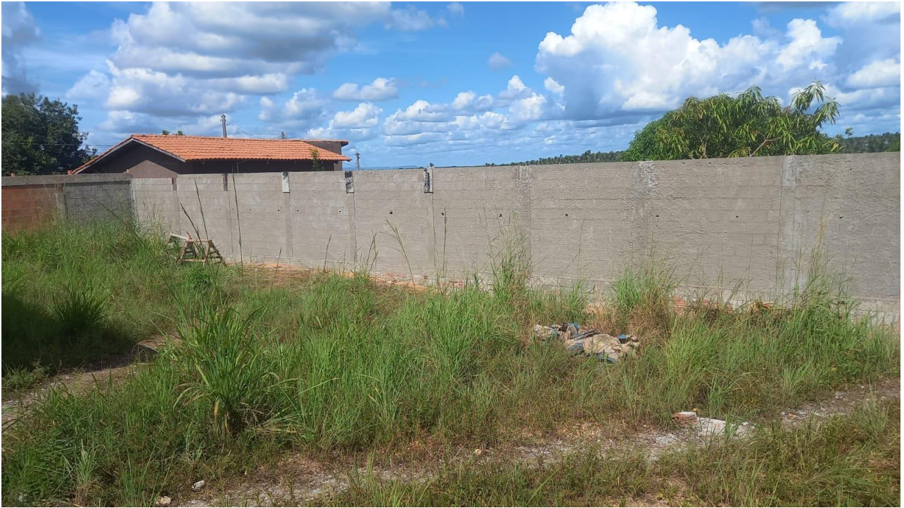
Figura 4. Concretagem das pontas dos pilares do muro de divisa.
